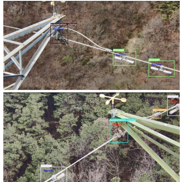
그림 3. AI 영상분석 기술을 활용한 OPGW 설비 진단
