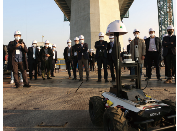
〈세종-포천 고속도로 14공구〉
