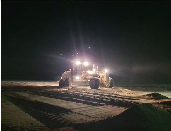
〈카타르 TSE 저류조 공사〉
